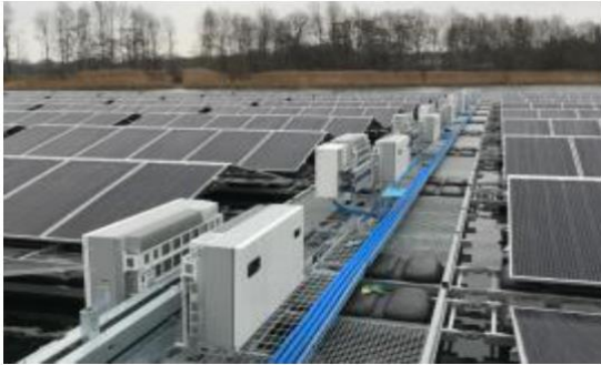
Foto von Wechselrichter (Beispielanlage)
