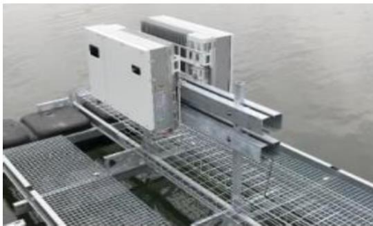
Foto von Wechselrichter (Beispielanlage)
