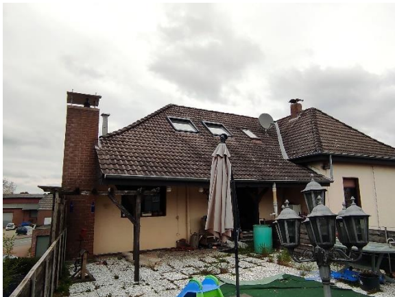
Foto 3: Blick von der Dachterrasse auf der Garage auf das Wohnhaus (eigene Aufnahme 18.04.2023)
