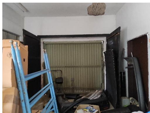
Garage/ Anbau fensterlos, nur mit Toröffnung
