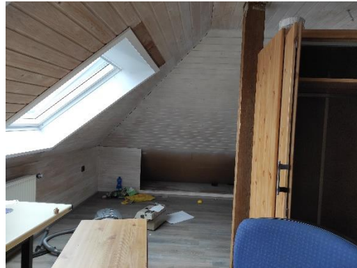
Ausgebauter Teil des Dachgeschosses
