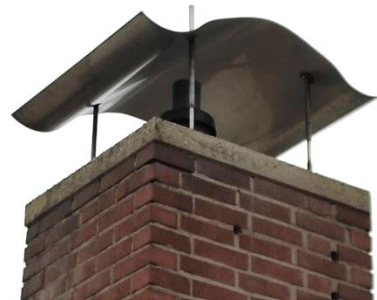
Foto 8: Gemauerter Schornstein (eigene Aufnahme 18.04.2023)
